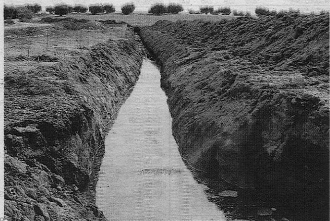
Se han abierto kilómetros de zanja en los últimos meses
