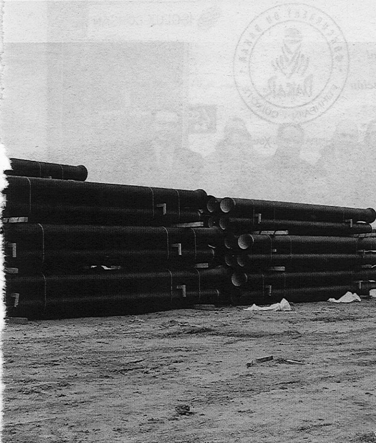
Las nuevas tuberías instaladas son de gran sección
