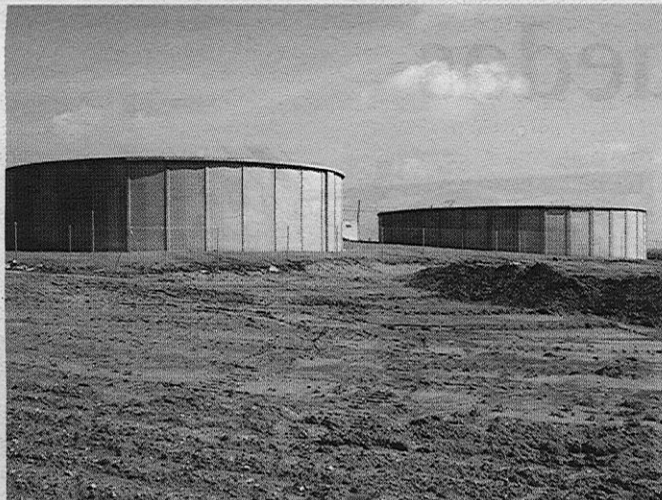
Depósitos de distribución de Añover y Alameda
