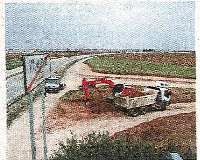
Obras a la entrada de la localidad de Villanueva de Alcardete. A. P. HERRERA
