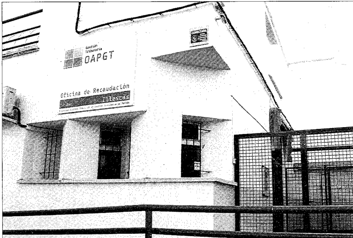
La infraestructura se ubicará en la calle Severo Ochoa s/n, emplazamiento del antiguo Consultorio Médico./R.C.
