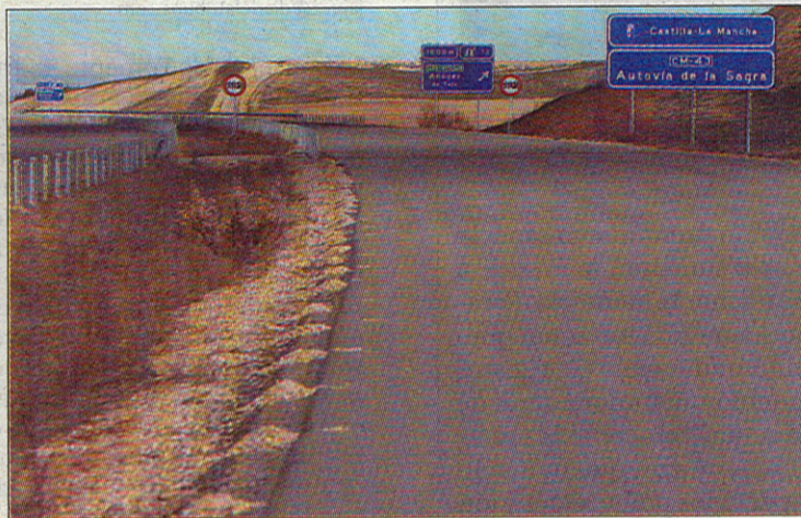
La obra en Añover permitirá abrir al tráfico dos kilómetros ya efectuados. /Y.L.
