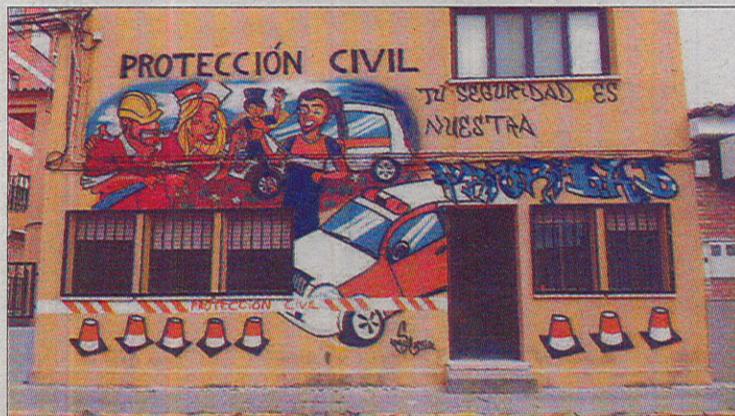
Fachada de la nueva sede de Protección Civil. / LT
