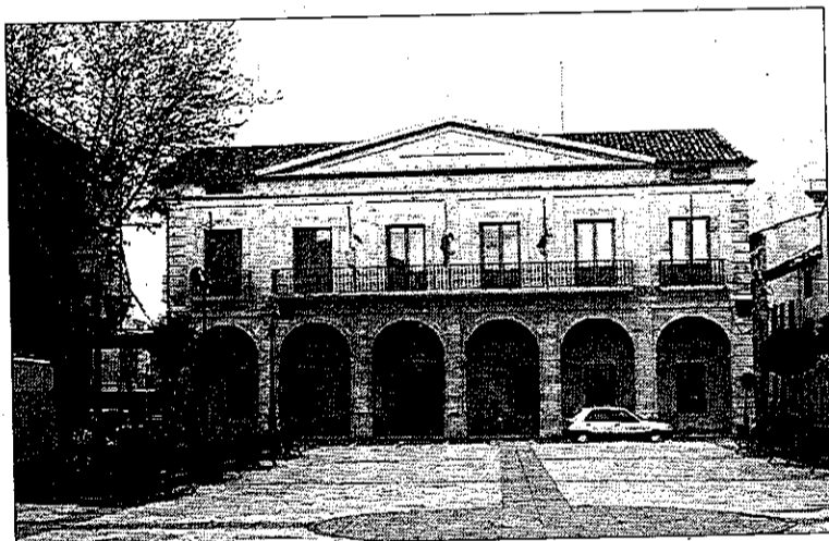
El Consistorio ha aprovechado los meses de verano para ejecutar algunas obras. / L.T.
