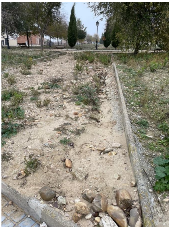
Imagen 4. Lavado del pavimento actual
